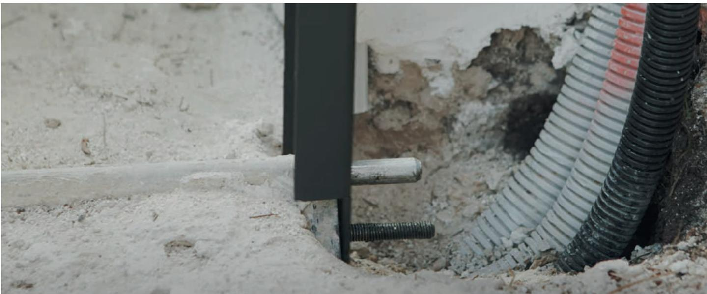
Atornillar la “U” de cierre con el tramo angular, teniendo en cuenta que una de sus caras va instalada al pilar. Poner el cajetín de la cerradura con los dos tornillos restantes.
