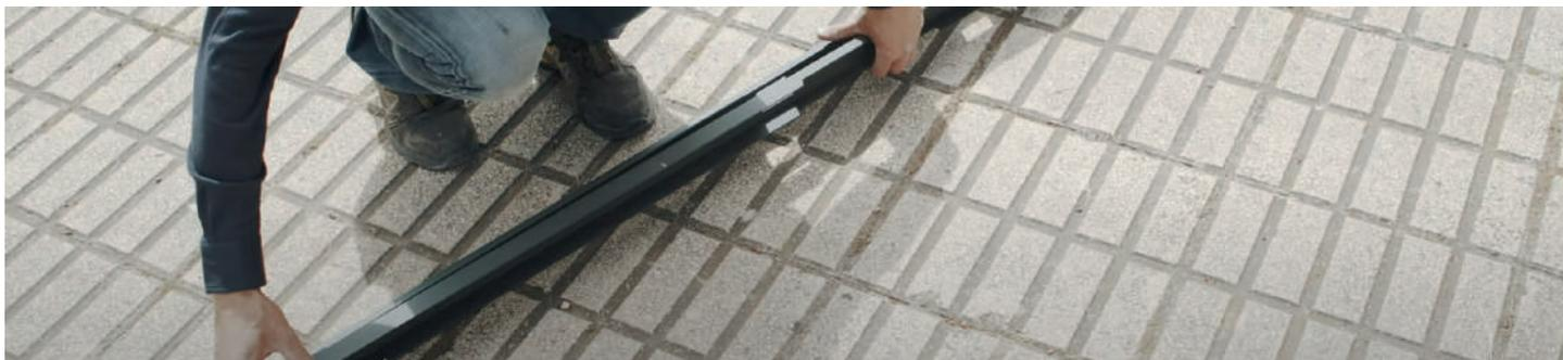
La pieza completa de “U” puede colocarse obrado con garras o atornillada directamente al pilar. Nos ayudamos de un nivel para ajustar la perfecta verticalidad de la “U”. Los colisos permiten un último ajuste fino de la verticalidad.
